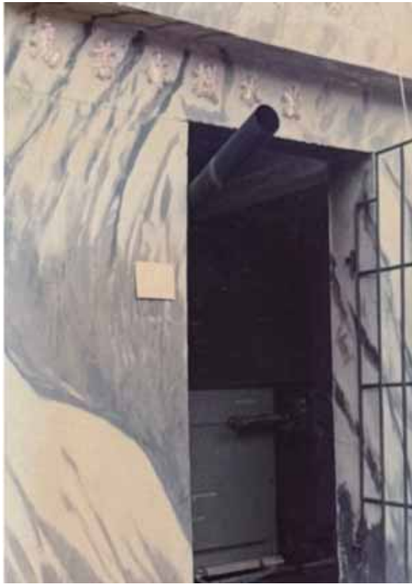
海水淡化作業使淡水源源不絕用之不竭
