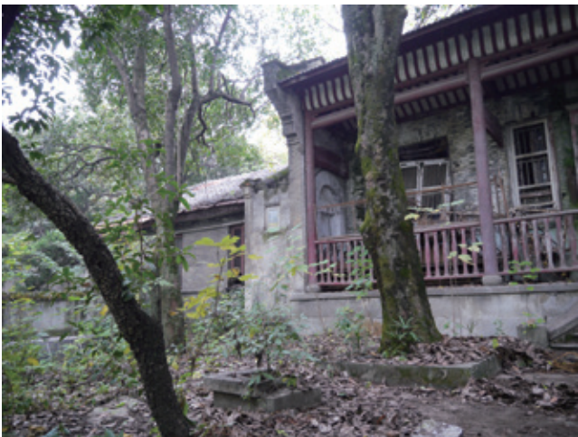
別墅整修前舊有場景之二
