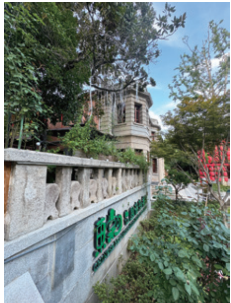
修復後的徐源泉公館外牆一隅
