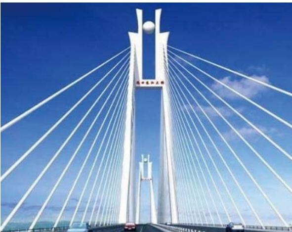
沌口長江大橋主橋長3,208米，結構為五跨一聯雙塔雙面鋼箱梁斜拉橋（照片摘自網路）
